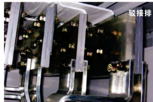
驳接排 在始端箱内部位置,用于母线槽与配电柜的连接,即:法兰部位与电柜出线排部位的连接。驳接排(又名:过渡排、硬连接)每个配电柜接口配1套
