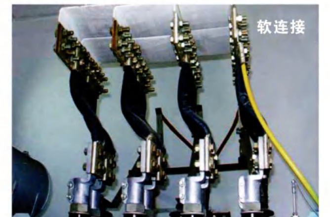
软连接 用于母线槽与变压器的连接,以消除变压器震动对母线槽的影响。每台变压器1套(每套件数根据电流而异,具体由基业配置)。
