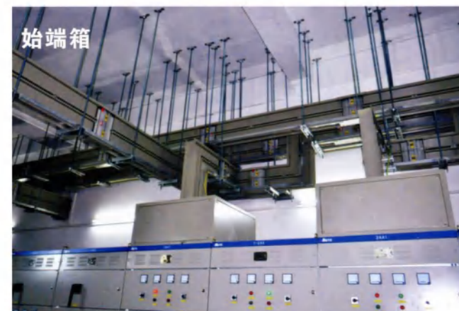
始端箱 在配电柜进线、出线的母线连接部位,箱体起保护作用,又名:进线箱、终端箱、末端箱;与母线槽始端数量相当。
