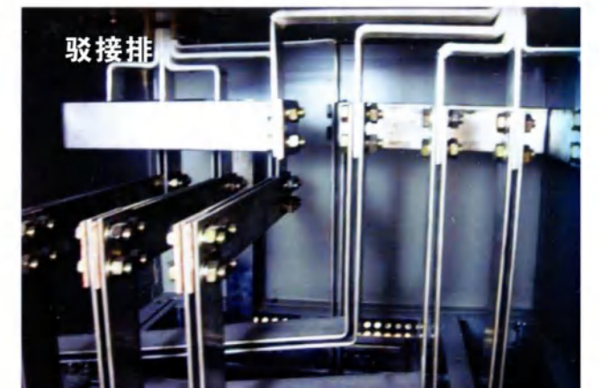
驳接排 在始端箱内部位置,用于母线槽与配电柜的连接,即:法兰部位与电柜出线排部位的连接。驳接排(又名:过渡排、硬连接)每个配电柜接口配1套
